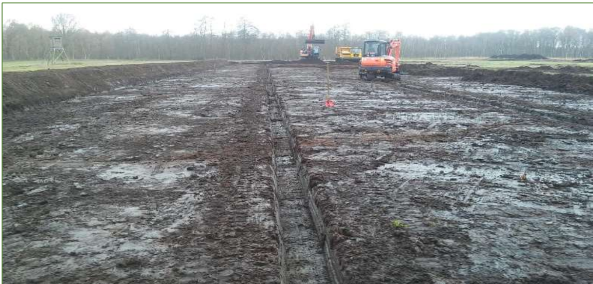
Abbildung 5: Oberbodenabtrag mit Hydraulikbagger und Kübelraupe (Foto: B. Hofer 2020)
