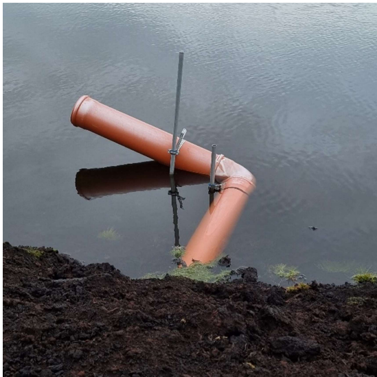
Abbildung 7: Regelbarer Rohrdurchlass
